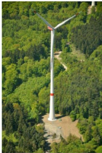
Figure 160 : Exemple des abords d'une éolienne en milieu forestier (source : ABO Wind, 2015)
