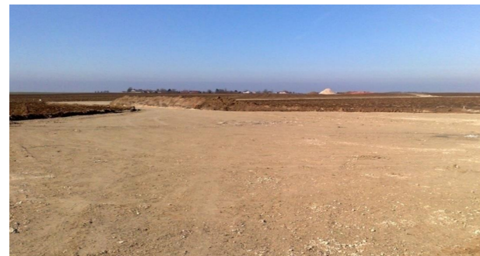
Figure 119 : Exemple d'aire de montage, grave compactée
