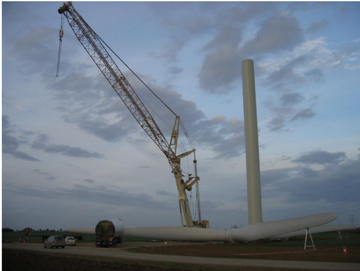
Figure 124 : Illustration d'un chantier
